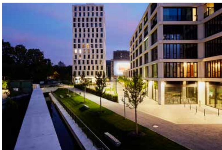
Abb.: Neben den drei Hochhäusern verfügen die restlichen Gebäude über sechs oberirdische Etagen. Die hellen Lichtpunkte entlang der Fassaden setzen eine prägnante Kontur aus Licht. Foto: Jost Hurler Gruppe
