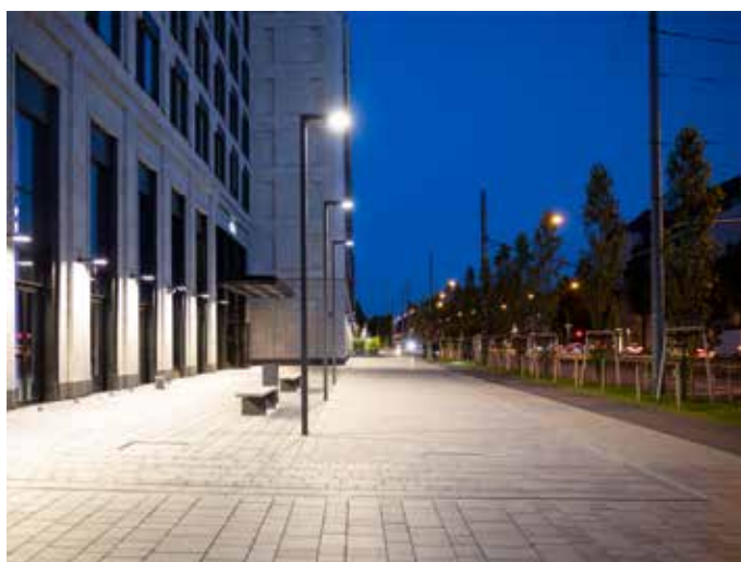
Abb.: Die Lichtpunkthöhen der Leuchten sowie die Abstände der insgesamt etwa 200 Lichtpunkte sind über das ganze Quartier hinweg gleich angelegt, um eine formale Durchgängigkeit zu erreichen. Foto: Johann Lichtl
