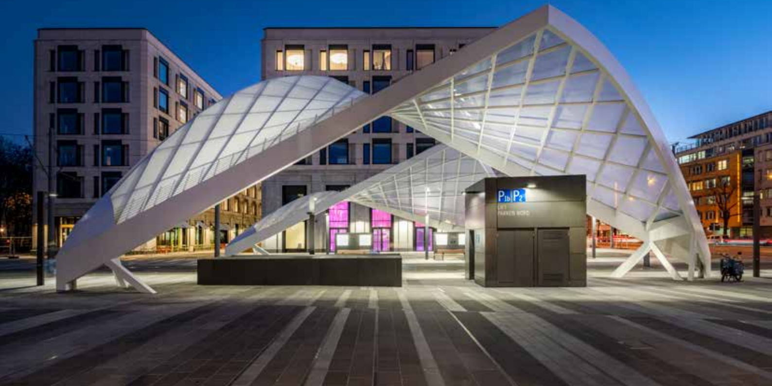
Abb.: Die zweigeteilte Überdachung der Tramhaltestelle schafft eine optische Verbindung, ihre Formgebung ist eine Anlehnung an das ehemalige, im Jahr 1817 abgerissene Stadttor »Schwabinger Tor«. Foto: Rainer Viertlböck
