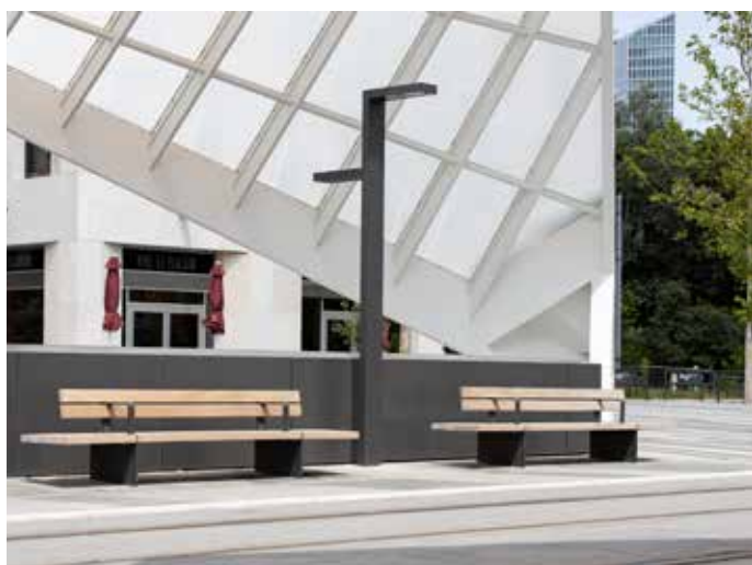
Abb.: Mastleuchten mit direkt und indirekt strahlendem Lichtanteil leuchten die Bahnsteige aus und lassen die mit ETFE-Folie gestaltete Dachkonstruktion als selbstleuchtend erscheinen. Foto: Johann Lichtl
