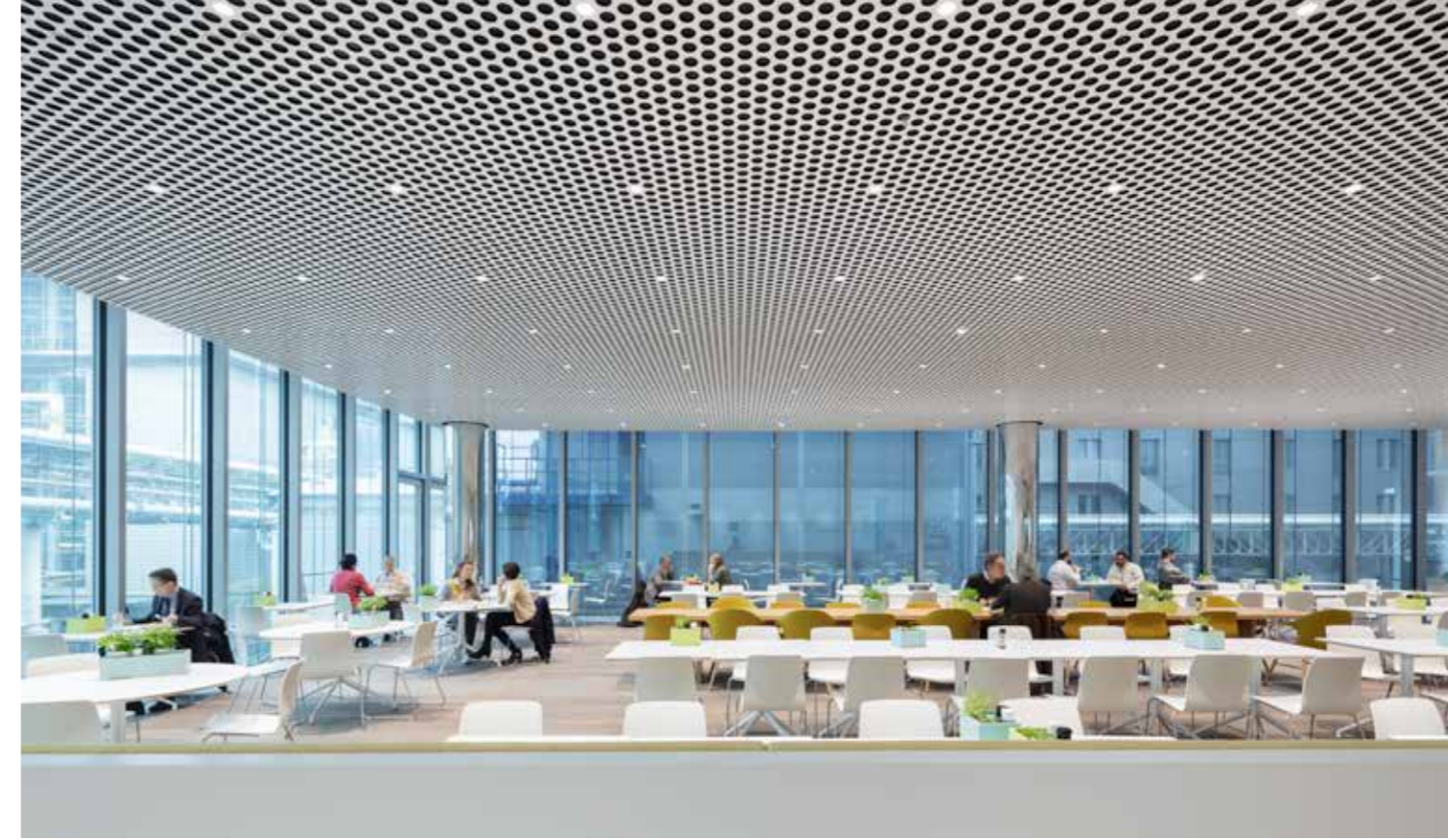
Abb.: Die Basis der Beleuchtung bilden 5.600 Downlights, die am Stützenraster ausgerichtet sind. Die passgenaue Übereinstimmung von Deckenaussparung und Downlight gewährleistet eine von Lumen3 speziell entwickelte Befestigungslösung.
